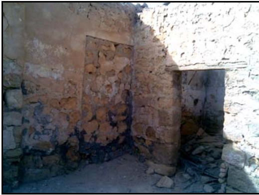
صورة رقم (١٢) حائط معالج باستخدام تقنية الترقيع
