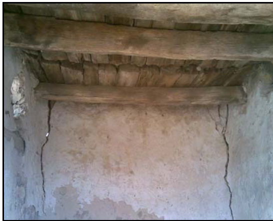
صورة رقم (٥) "السقف" خشب النخيل المادّة الأساسية
